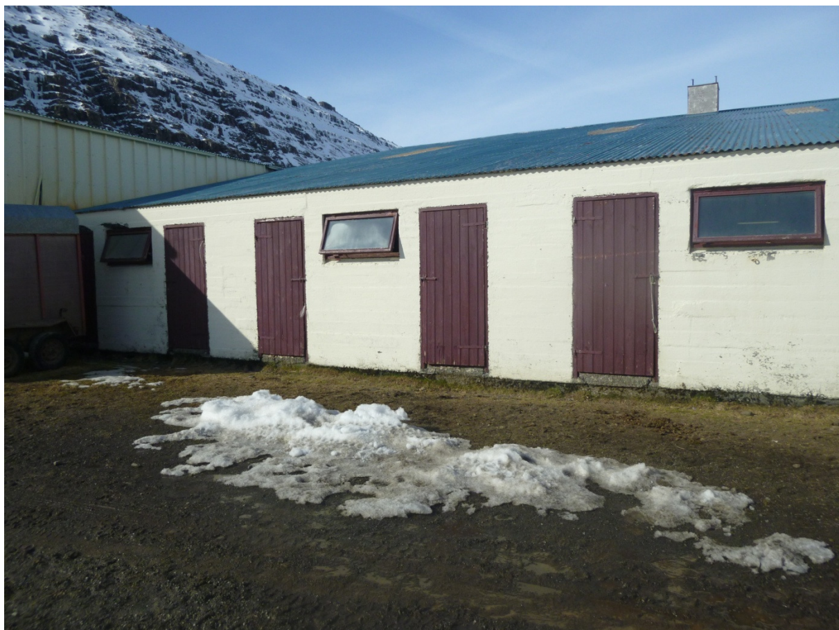
Mynd 1 Fjárhúsið á Sléttu
