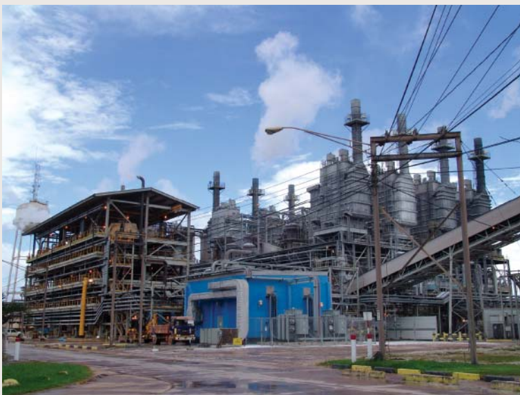
Het eindstation in de productieketen van aluinaarde, de afdeling Calcination. Links de pan filter building, die in het kader van de Plant Expansion werd opgezet.
