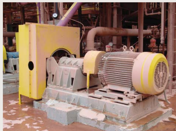
slurrypomp die aan een schoonmaakbeurt toe is
