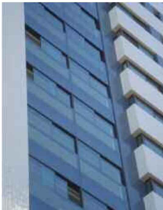
● A Linha Extrema, sistema de esquadrias com vidro colado, é fácil de montar e tem design diferenciado
