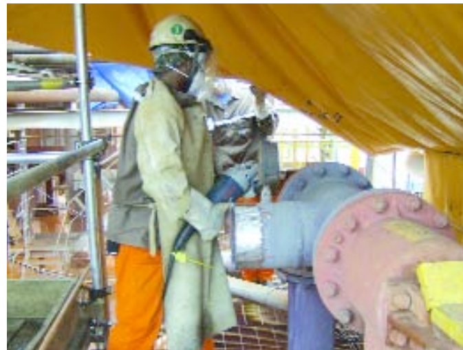
> INTERLIGAÇÕES | Funcionário executa ação de tie-in
