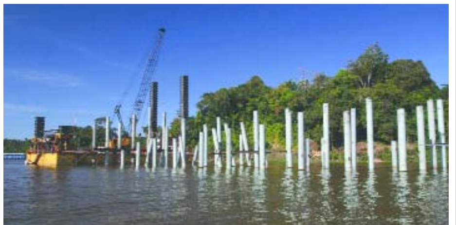
> PUERTO | Estacas que servirán de apoyo al atracadero
