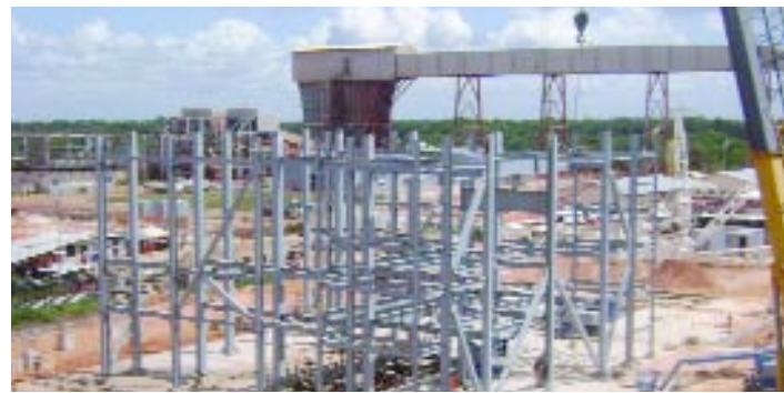
> ESTRUCTURA | Inicio del Montaje Electromecánico
