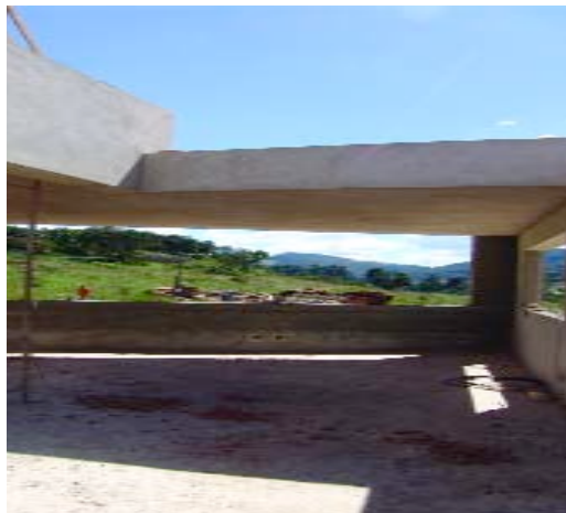
> PRÉDIO DO LABORATÓRIO | Detalhe da área interna da obra
