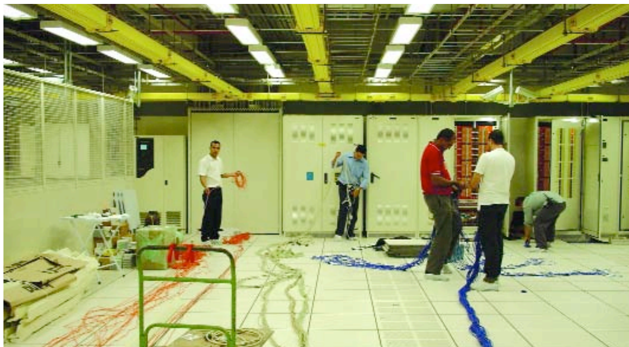
› INFRAESTRUCTURA | Cambio (abajo) e instalación de los equipos del SADC (arriba)
