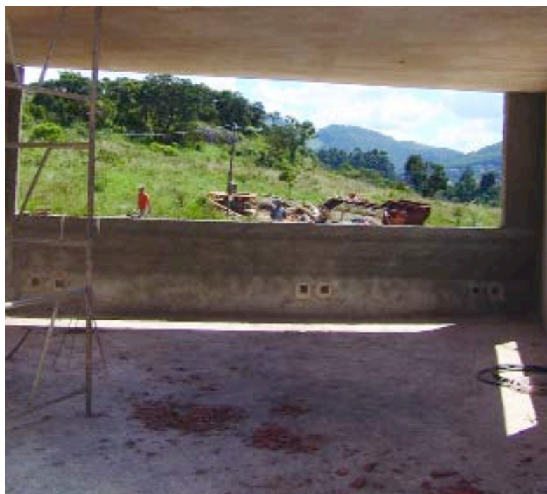
> EDIFICIO DEL LABORATORIO | Detalle del área interna de la obra
