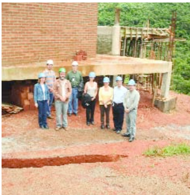
> POÇOS DE CALDAS | Visita a las obras de la construcción del Laboratorio del Jardín Botánico.
