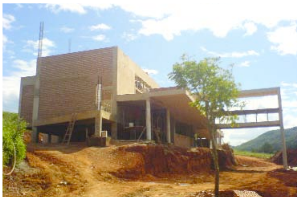
> INVESTIGACIONES CIENTÍFICAS | Vista de la obra del Laboratorio de Investigaciones Científicas
