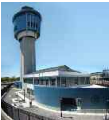
● A torre de controle do aeroporto de LaGuardia é revestida com Reynobond
