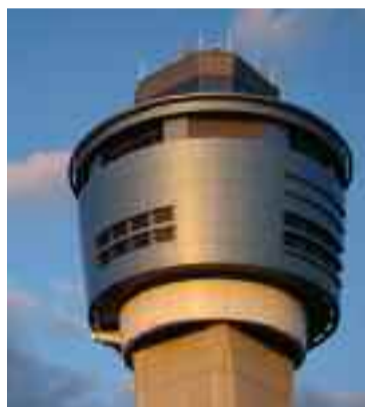
● A torre de controle do aeroporto de LaGuardia é revestida com Reynobond
