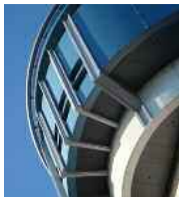
● A torre de controle do aeroporto de LaGuardia é revestida com Reynobond
