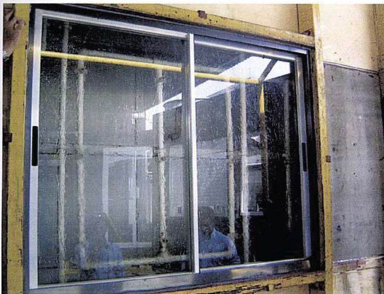
Foto nº. 03 Verificação da estanqueidade à água.
