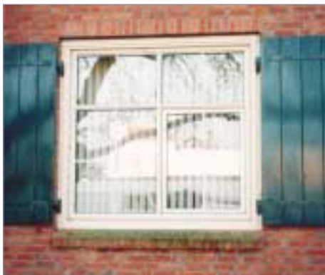
renovatie Gemeentehuis Raamsdonkveer
