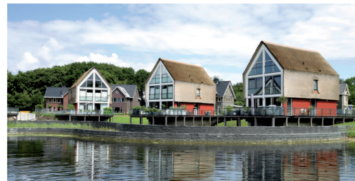
De Bunte / De Parelhorst, Nunspeet Architect: Inbo, Drachten Alcoa ramen, deuren en gevels
