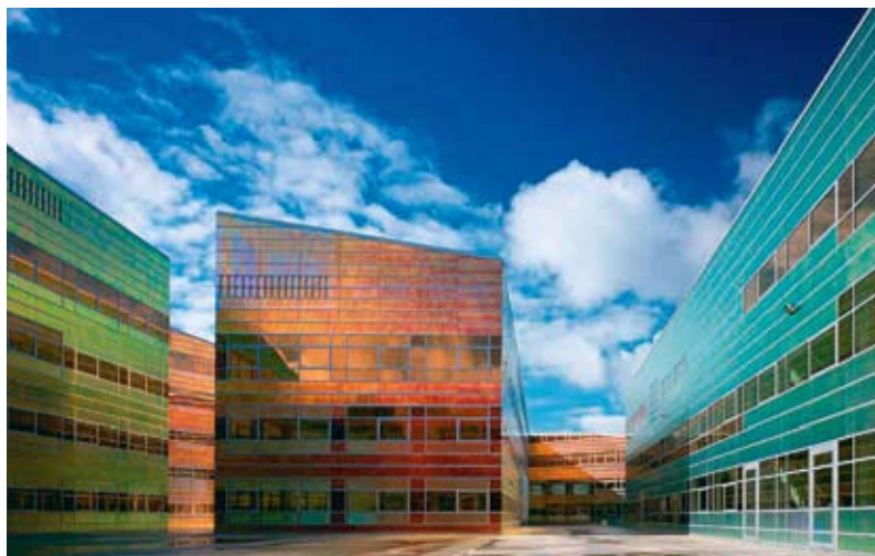
La Defence in Almere, ontwerp UN Studio, brandwerende gevelelementen toegepast in combinatie met niet-brandwerende. Het verschil is aan de buiten- en binnenzijde van het gebouw niet te zien
